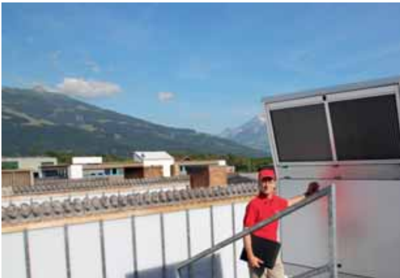
Anlagensanierung Hoval RoofVent alt gegen neu.
